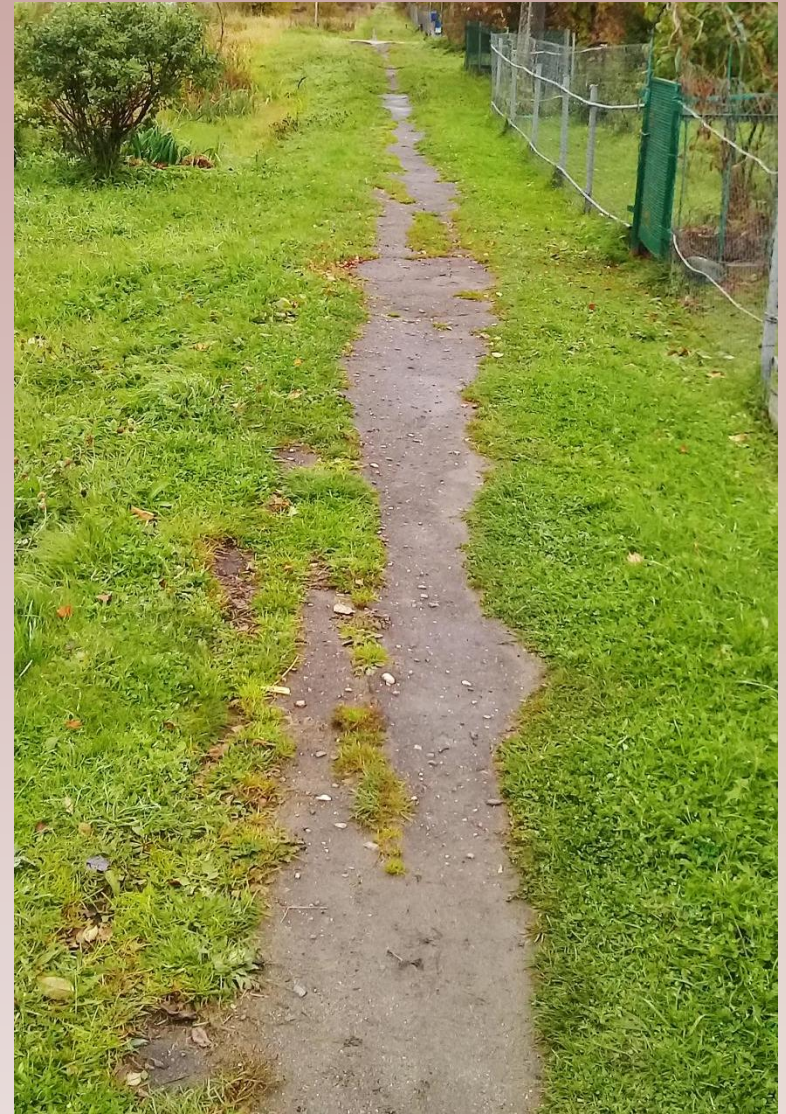
Ремонт тротуара в д. Пирогово
