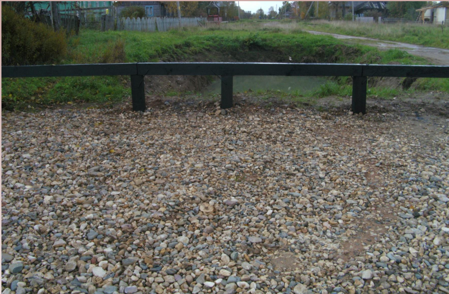
Устройство пожарного водоема д.Тимонино
