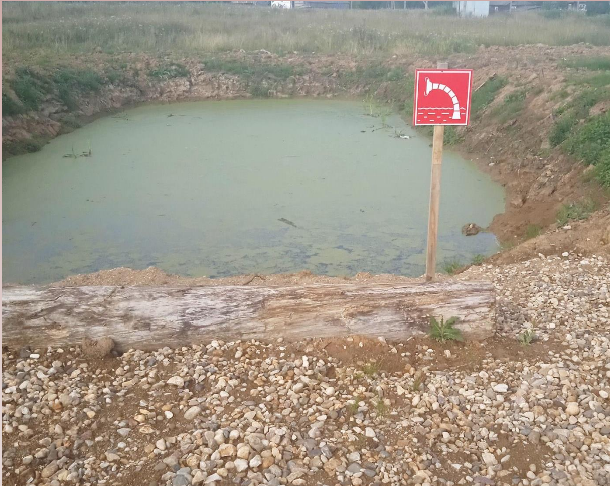
Устройство площадки у пожарного водоема в д.Слобода
