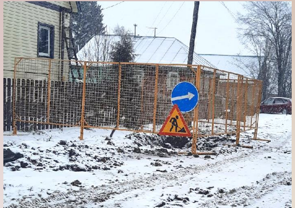
Распределительный газопровод ул.Володарского г.Грязовец
